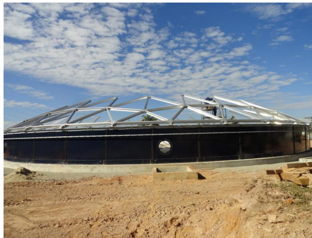
Vista da fachada do reservatório Franco da Rocha-Vila Santista.
