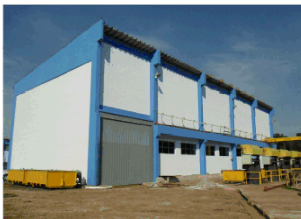
Fig. 4. Vista externa da casa de bombas
