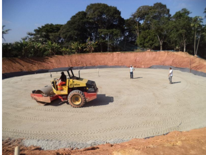
Acompanhamento da construção da base da ampliação do Centro de reservação Embu-Guaçu.
