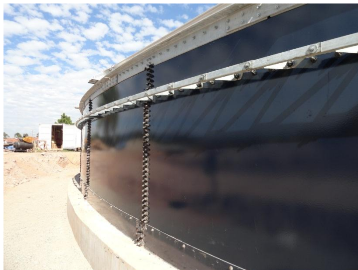
Vista da fachada do reservatório Franco da Rocha-Vila Santista.
