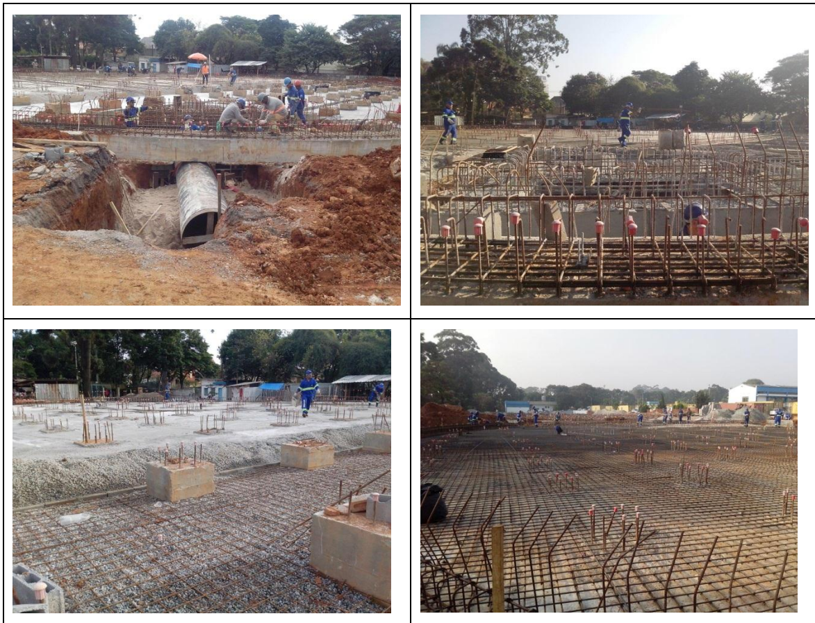
Obras da fundação para os novos Reservatórios ETA RJCS
