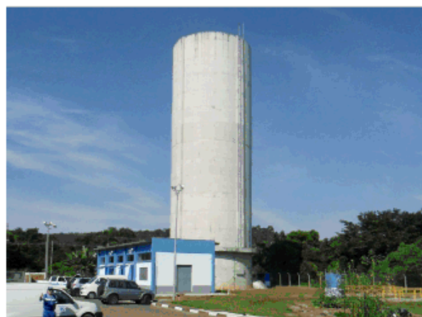
Fig. 5. Vista da Chaminé de Equilíbrio (CEQ) de 11,0m de diâmetro e 35,1m de altura
